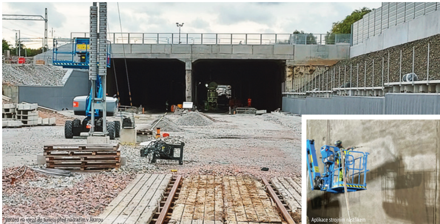
Pohled na vjezd do tunelu před nádražím v Åkarpu
